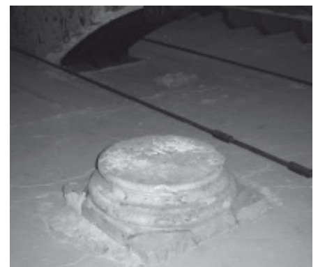
Fig. 3 – Base della colonna all'interno della vecchia infermeria (piano intermedio tra il cantinato e il primo).
