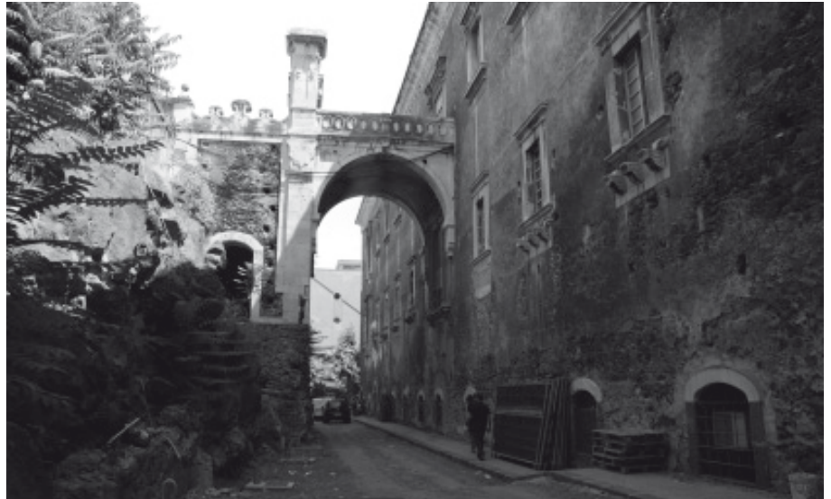
F. 10 - Ponte di collegamento del monastero con la "Flora" realizzata sopra la colata lavica del 1669. I monaci, dopo aver rimosso la "sciara" con il "tritolo insino alla facciata" tra il 1672 e il 1678, a partire dal 1678, fecero trasportare la terra vegetale per ricostruire i loro "giardini" distrutti dal "Foco di Mongibello" (foto di O. Valentini).
