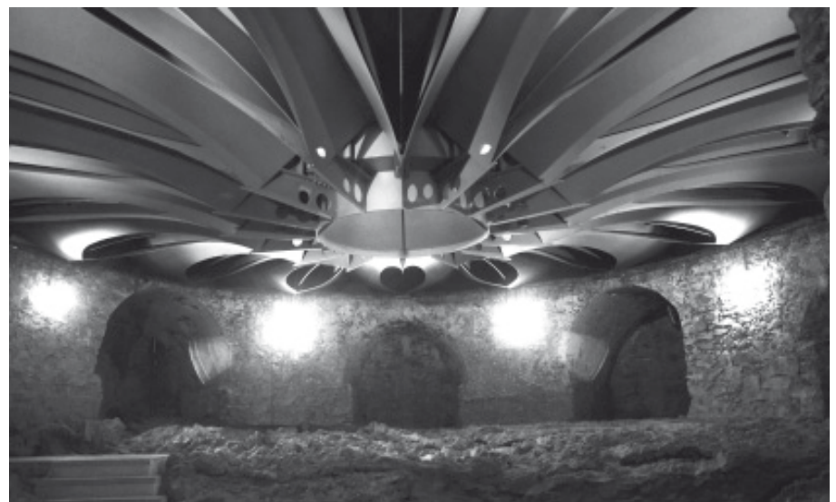
F. 7 - Struttura metallica del piano di calpestio dell'antirefettorio a pianta circolare (foto di O. Valenti).
