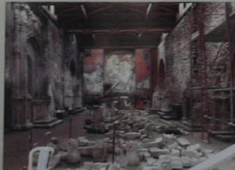
3° campagna di scavi copertura navata completata ed inizio restauro lapideo 14-11-2015
